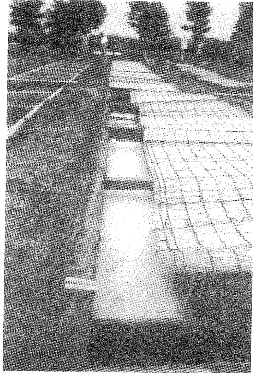
図6 浮遊型二酸化チタン光触媒の設置(6/18~)
