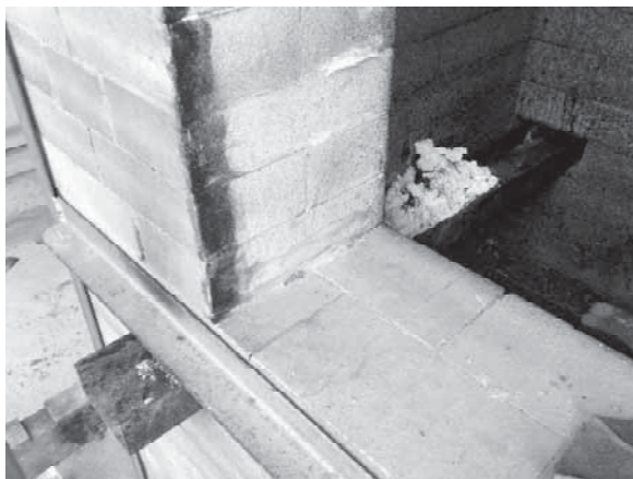
図 2 燃焼室と焼成室の間に渡した溝形鋼
