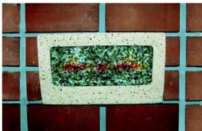
図4 廃ガラスを利用した壁面照明器具
