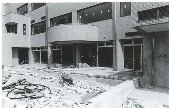
工事中のエントランス
