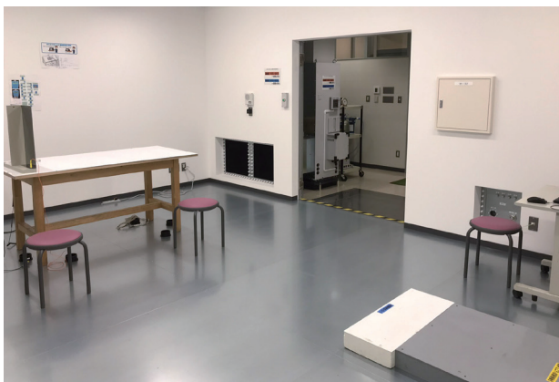
写真11 シールドルーム
