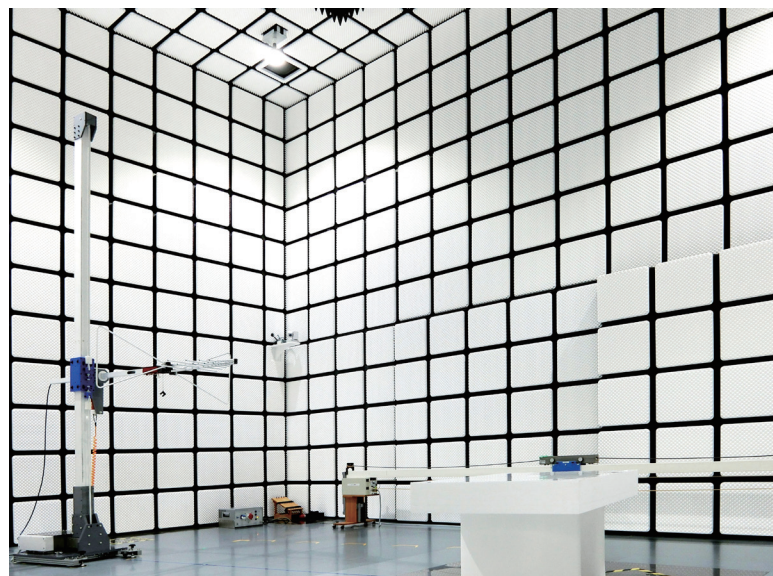
写真1 改修工事後の3m法電波暗室
