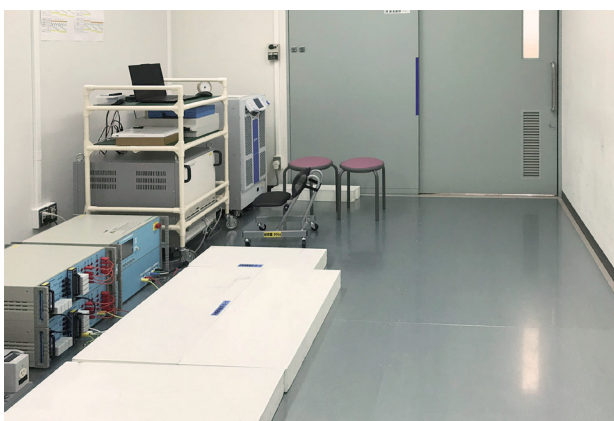
写真13 グランドプレーン室
