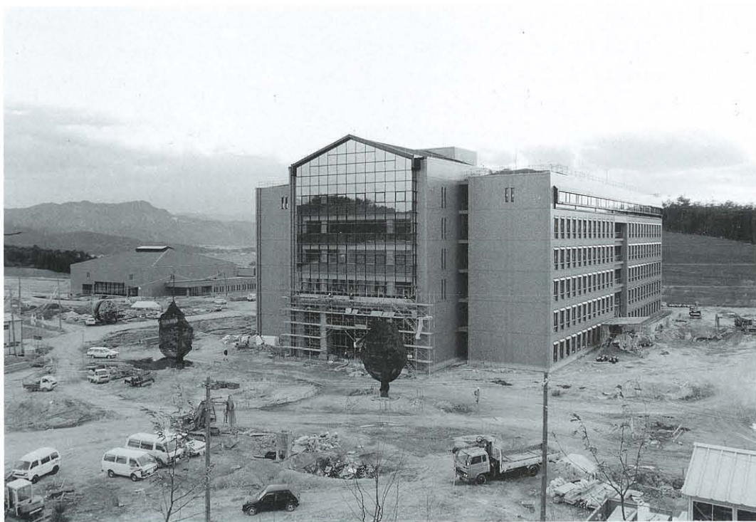
図2 建設が進む瀬田キャンパス(S63.12.撮影)
